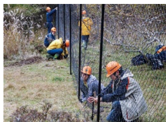
植生保護柵の設置
